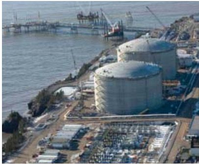
LNG storage tanks
