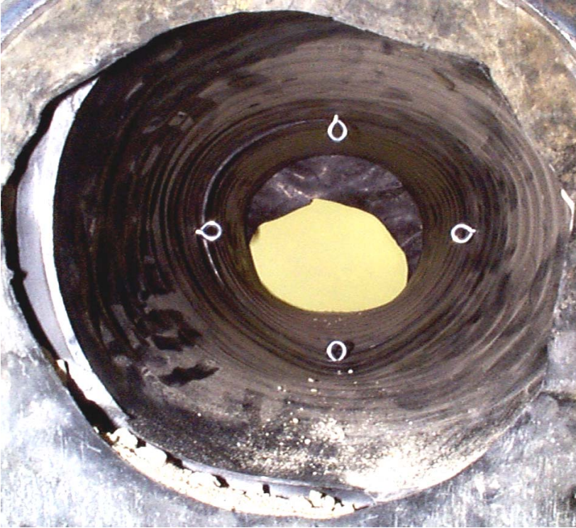
Foto 2: Tuberías después de la Carga de 2 000 kPa
